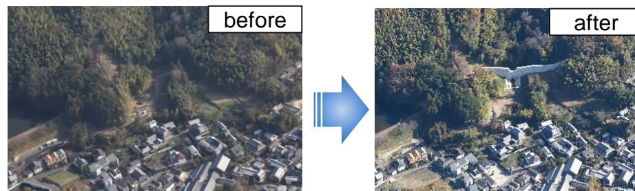
土砂災害対策として砂防堰堤等を整備
